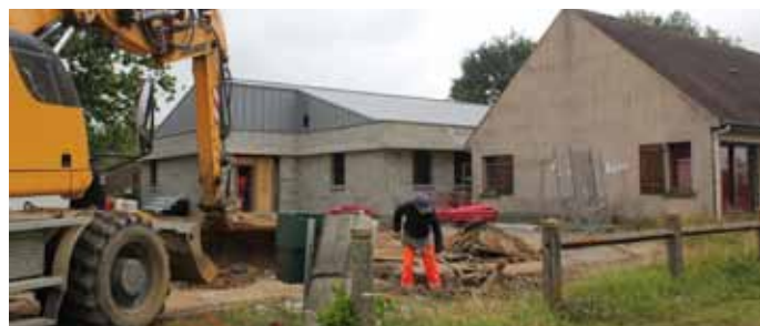
Commencés en juin 2019, les travaux du site de Val-au-Perche s'achèveront début 2021.
