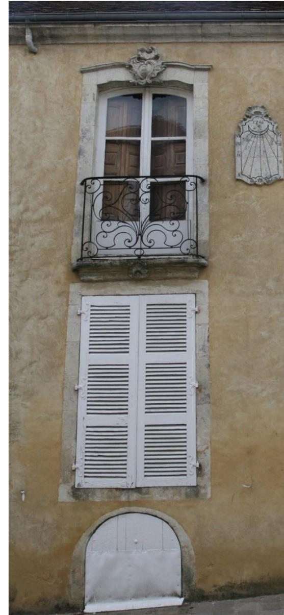
22, rue d'Alençon - Le cintre des menuiseries respecte le profil de style Rocaille de l'arc de la fenêtre
